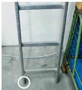
Bild 1: Fehlender Fuß – Leiter nicht verwendungsfähig!
