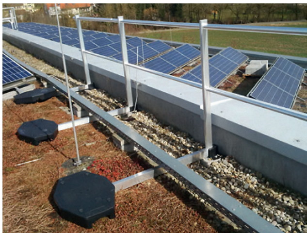
Mobile Umwehrung an Photovoltaik-Anlage (Abb. 5)
