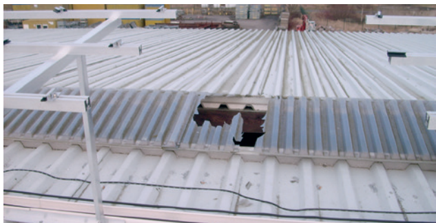
Nicht betretbare Lichtkuppel mit Bruchstelle (Abb. 4)
