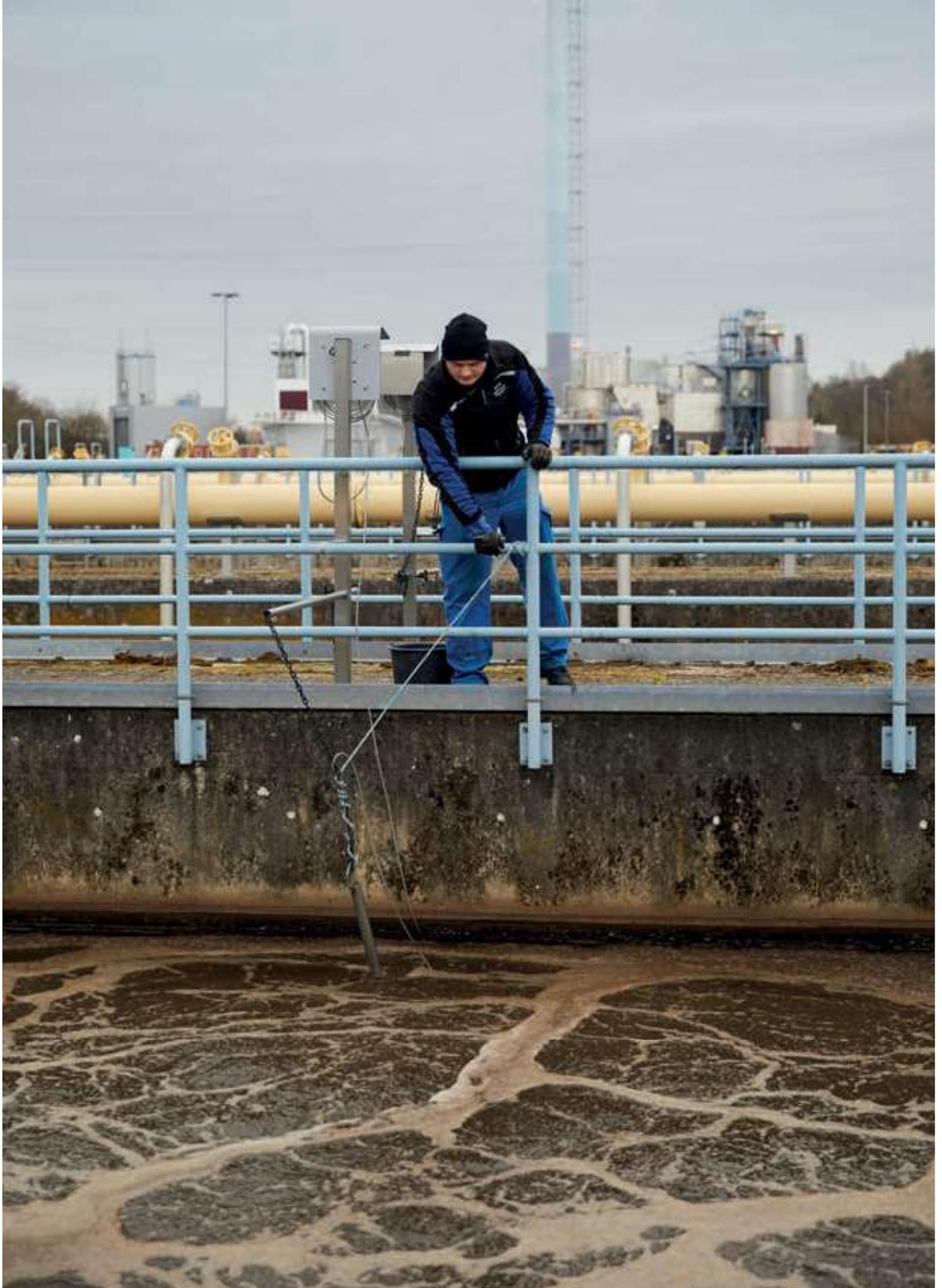
Gefahrenpunkt Belebungsbecken: Wegen der Einperlung der Luft und der dadurch entstehenden Turbulenzen ist das Schwimmen im Becken erschwert.
